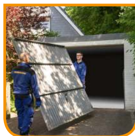
Ausbau und umweltgerechte Entsorgung
